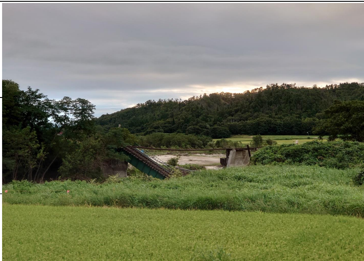
米坂線 小白川橋梁
